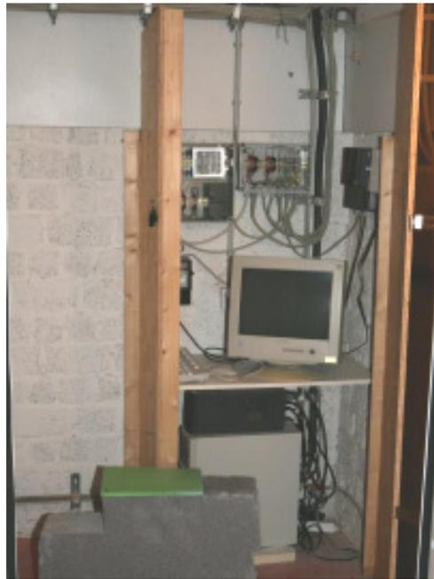
**Abbildung 7: Messrechner mit unterbrechungsfreier Stromversorgung (USV), Bus-Master und zentraler Spannungsversorgung der Sensoren sowie Telefonanschluss zum Datentransfer im Keller von Haus 50.**
