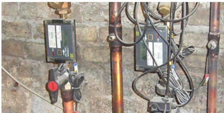
**Abbildung 8: Im Heizungskeller montierte zentrale Wärmemengenzählern (WMZ) in noch ungedämmten Leitungen.**
