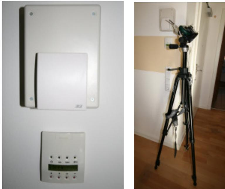
**Abbildung 13:** Montierter Kombisensor mit Bus-Umsetzer (links) und Messaufbau einer der Kalibriermessungen (Temperatur und relative Feuchte) in einer Wohnungen des 4er Blocks. Unter der Temperaturmessstelle befindet sich die Steuereinheit des Lüftungsgerätes der Wohnung.
