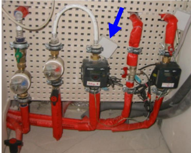
**Abbildung 12:** Installierte Wärmemengen- (schwarz) und Wasserzähler (rund) in einer der 19 Wohnungen im 4er Block. In der Installationsdose hinter dem WMZ in der Bildmitte (Pfeil) befindet sich der gewickelte Konstantanwiderstand für die Warmwassermessung. Der rechte WMZ erfasst den Verbrauch für die Beheizung der Wohneinheit.
