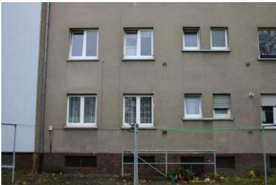
Abbildung 36: Rückseite (Nordfassade) von Hauseingang 36. Links grenzt die sanierte Fassade des Nachbargebäudes an.
