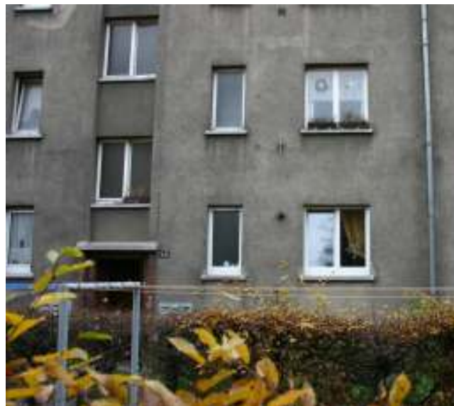
Abbildung 42: Ausschnitt der Ostfassade von Block 48-54 im Bereich von Haus 48 rechts.
