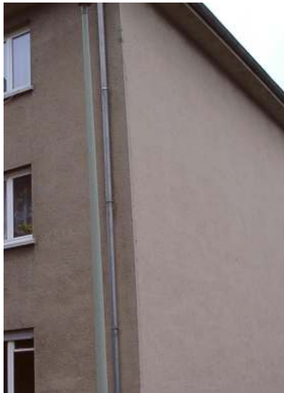
Abbildung 40: Nördliche Giebelwand von Block 48-54 von Ost.
