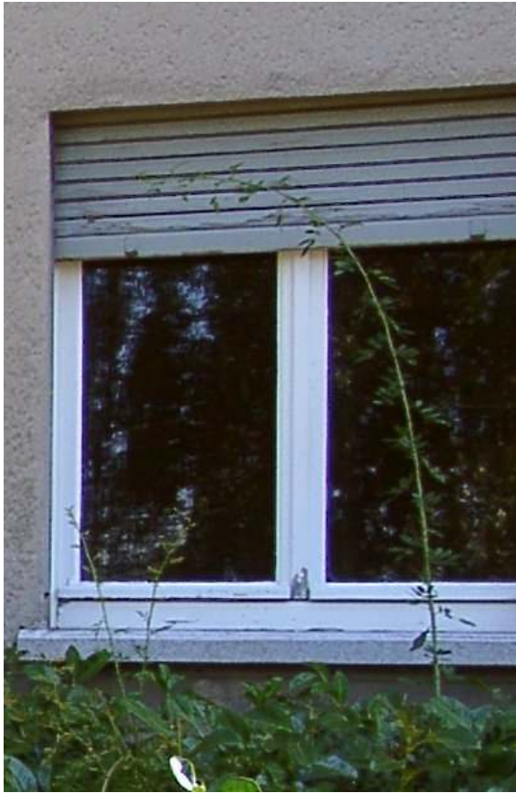
Abbildung 7: Holzfenster mit originalem innenliegendem Holzrolladen im Bestandsgebäude
