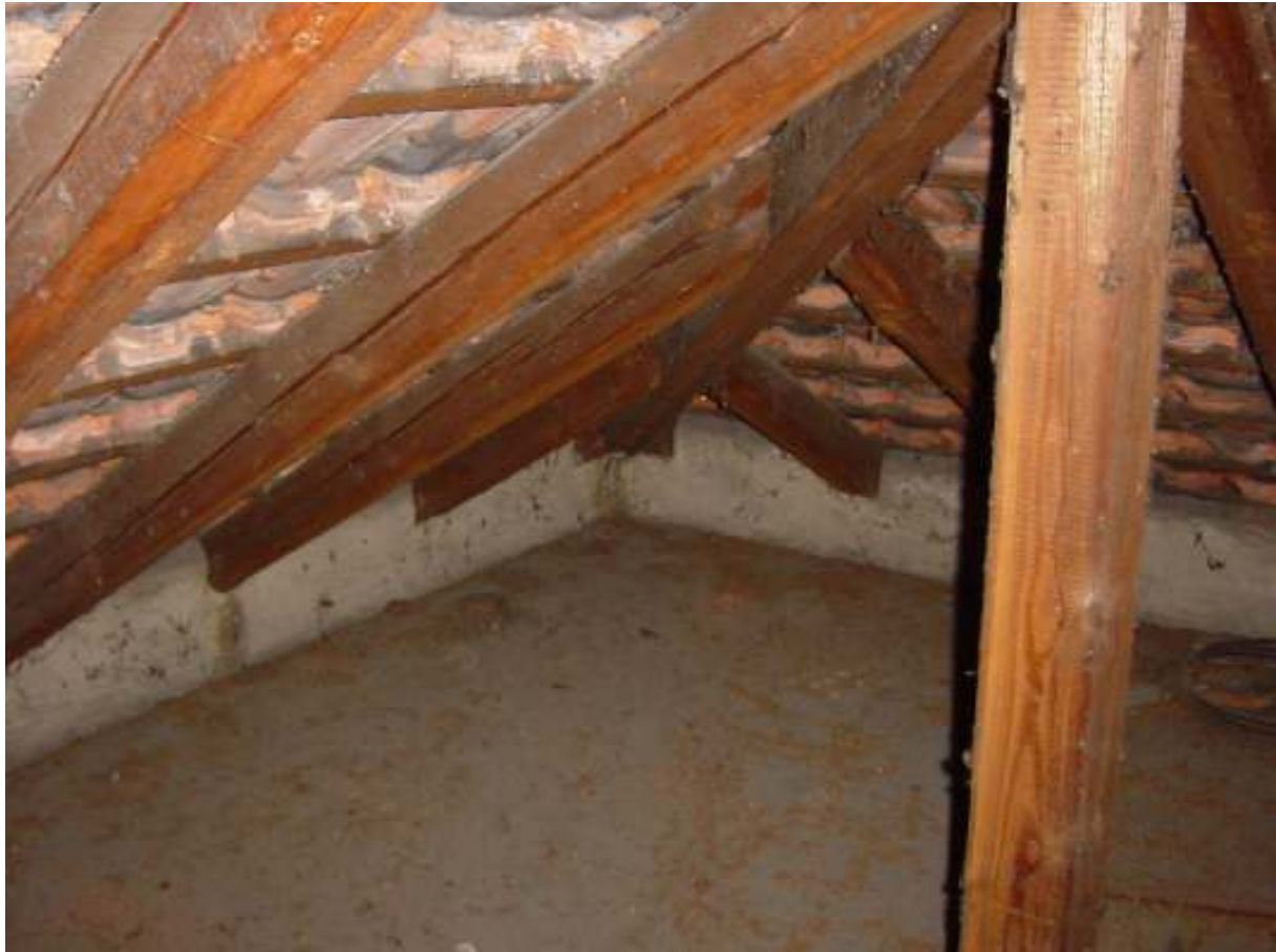
Abbildung 13: Dachstuhl und oberste Geschossdecke als Stahlsteindecke
