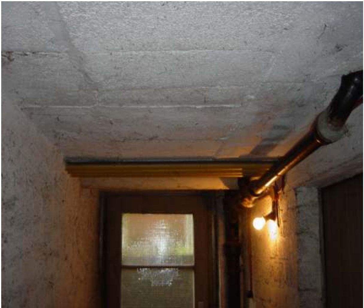
Abbildung 14: Kellertür (Abgang Treppenhaus) und Stahlsteindecke (System Kaiser)
