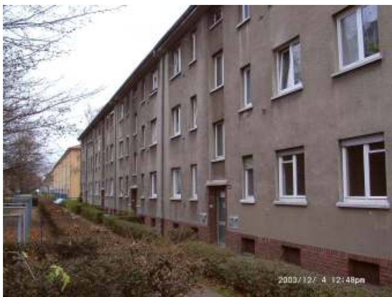
Abbildung 41: Ansicht der Ostfassade von Block 48-54 von Norden.
