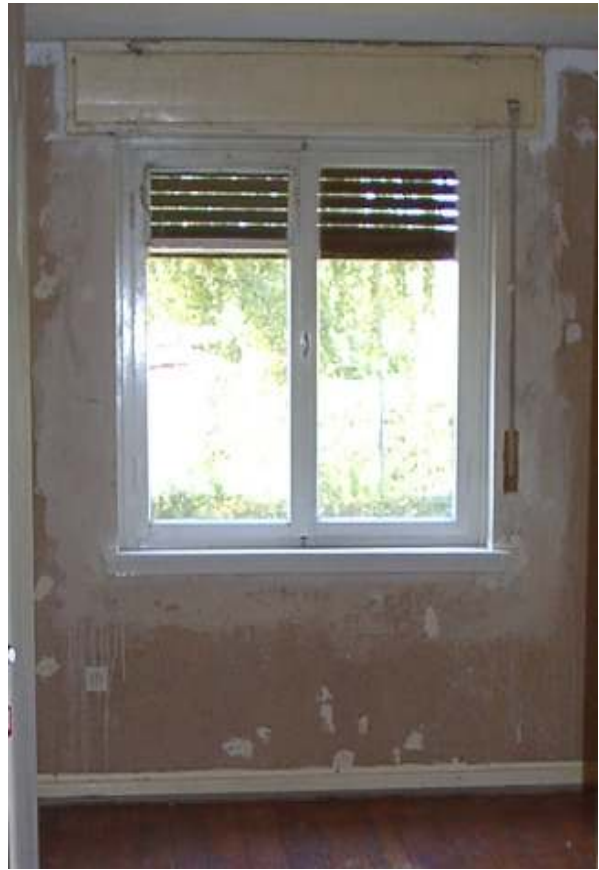
Abbildung 7: Holzfenster mit originalem innenliegendem Holzrolladen im Bestandsgebäude
