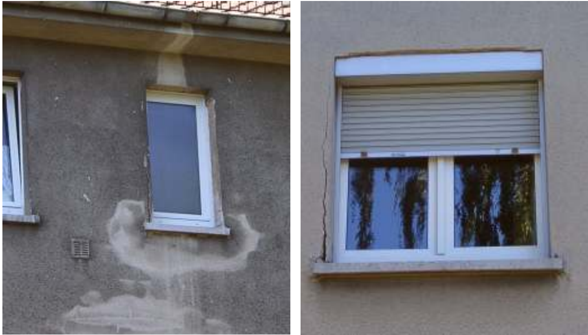
Abbildung 9: Nachträglich eingebaute PVC-Fenster im Bestandsgebäude (links: ausgebrochene Laibung, rechts mit nachträglich installiertem Rolladenkasten)
