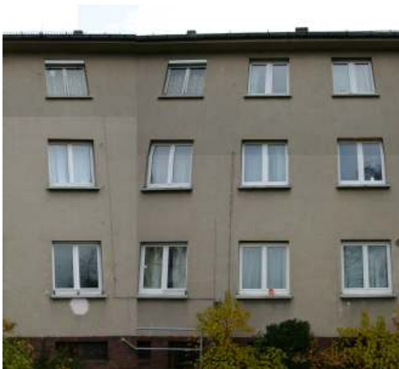
Abbildung 39: Ausschnitt der Westfassade im Bereich von Haus 50.
