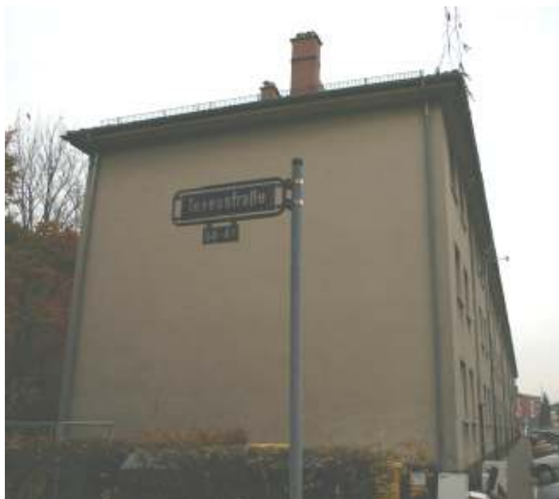
Abbildung 35: Westliche Giebelwand von Block 36-46
