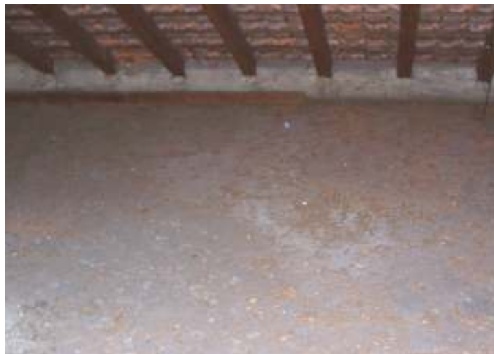
Abbildung 55: Dachboden von Haus 46 mit oberster Geschossdecke.
