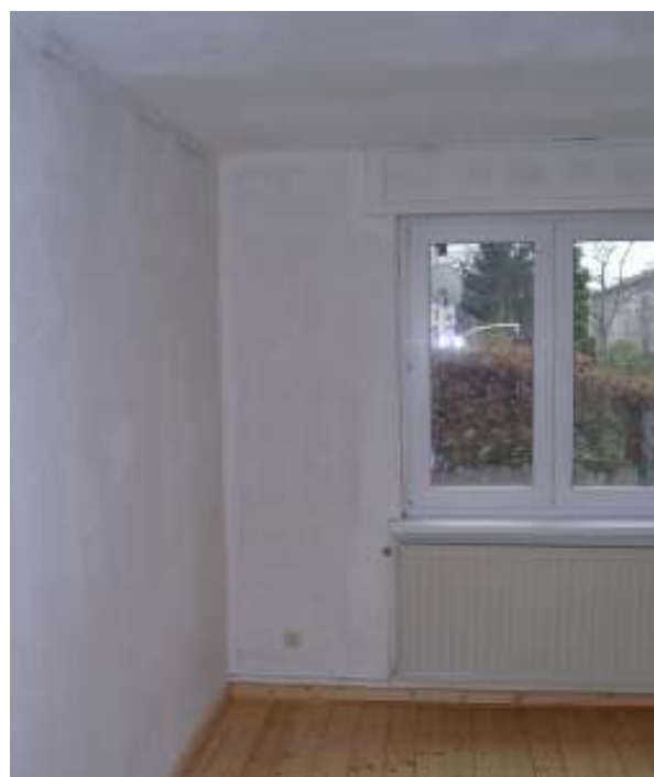
Abbildung 50: Wohnraum Richtung Süden (Innenwand zum Nachbarraum und Außenwand nach Süden)
