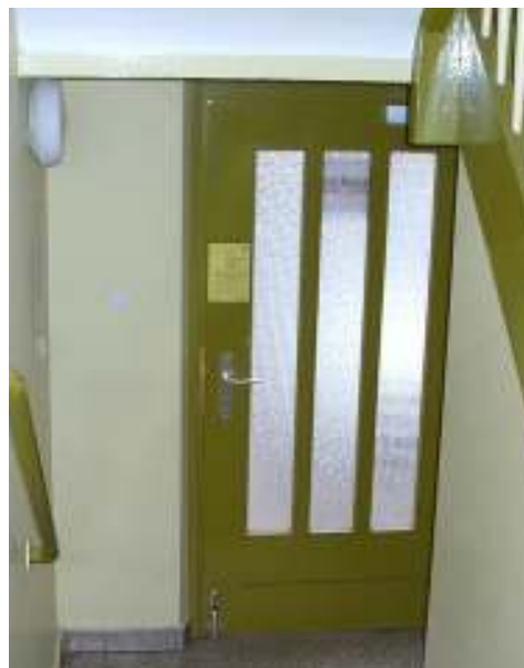
Abbildung 49: Holzhaustür vom Treppenhaus aus gesehen.
