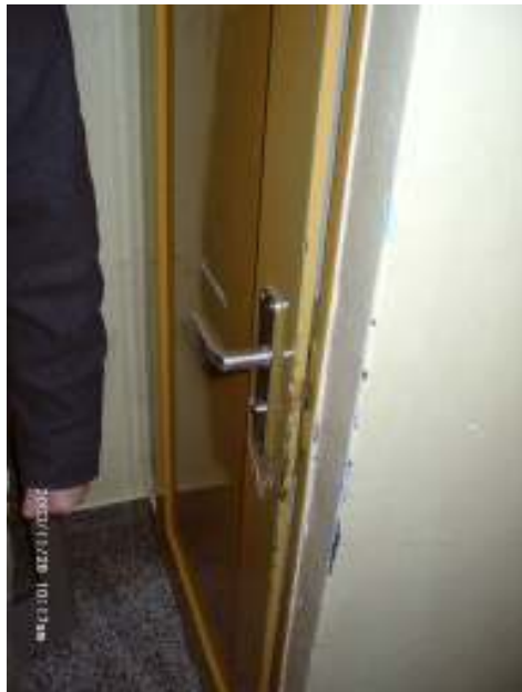
Abbildung 27: Leckagen an der geschlossenen Kellertür im Treppenhaus und am Treppenhausfenster.
