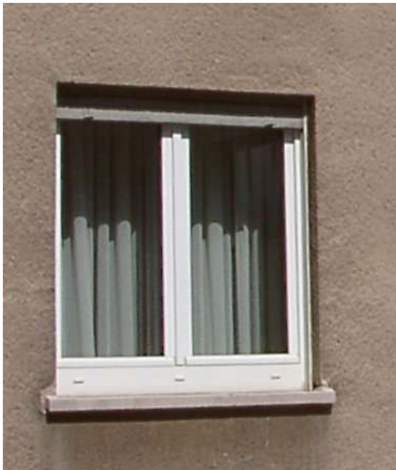
Abbildung 8: Nachträglich eingebaute Kunststoff-Fenster (Holzrolladen original)
