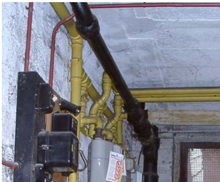
Abbildung 46: Decke Kellerflur in Haus 46 in Richtung Norden unter der linken EG Wohnung.
