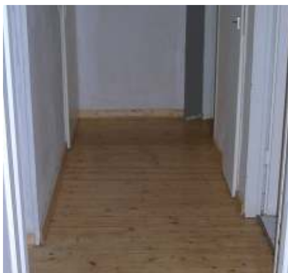
Abbildung 52: Wohnungsflur in Richtung Haustür (hinten links) mit Blick auf die Trennwand zur Nachbarwohnung.
