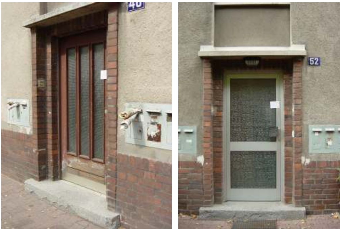
Abbildung 12: Holz- und Aluminiumhauseingangstür im Bestandsgebäude
