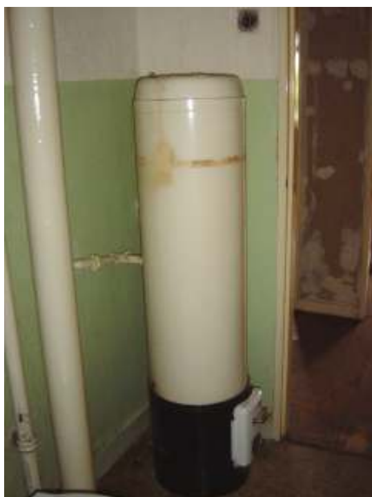
Abbildung 57: Kohle-Badeöfen und Gasetagenheizung im Bestandsgebäude
