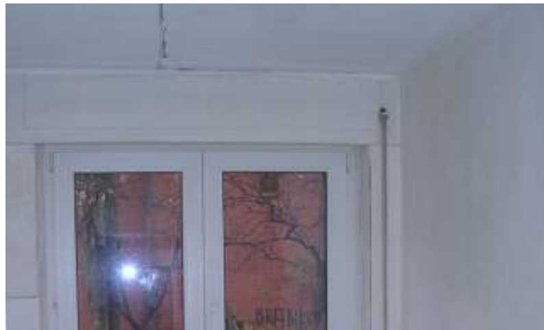
Abbildung 51: Detail Küchenfenster mit Rolladenkasten und Gurt in der Nordfassade.
