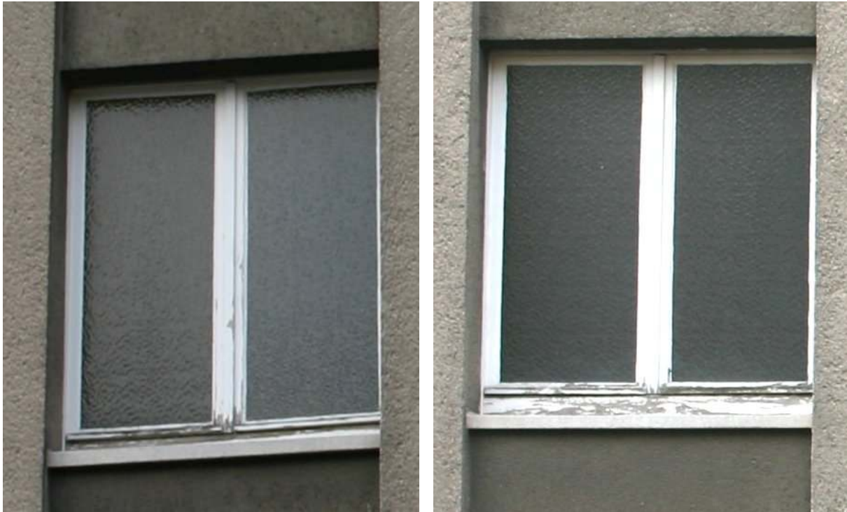
Abbildung 11: Einfach-verglaste Treppenhausfenster mit Holzrahmen
