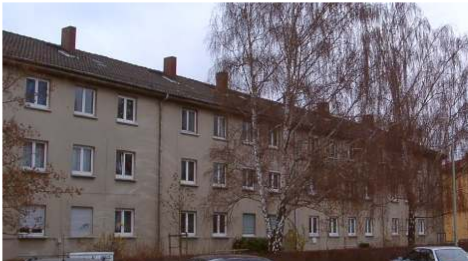
Abbildung 38: Übersicht über die Westfassade des Blocks 48-54
