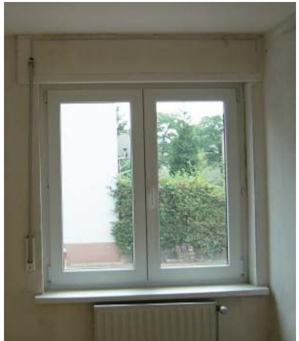
Abbildung 8: Nachträglich eingebaute Kunststoff-Fenster (Holzrolladen original)
