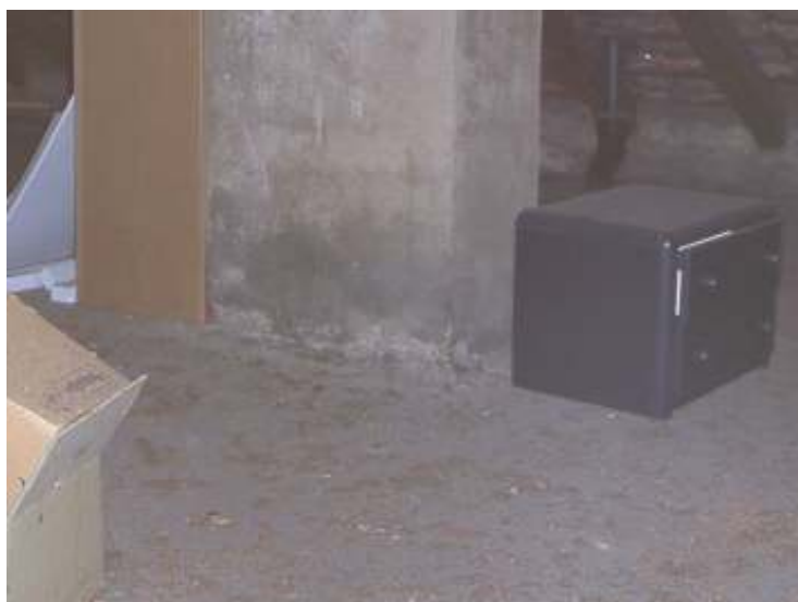
Abbildung 56: Dachboden von Haus 46 mit oberster Geschossdecke, genutztem Kaminschacht und Abwasserstrang-Belüftungsrohr.
