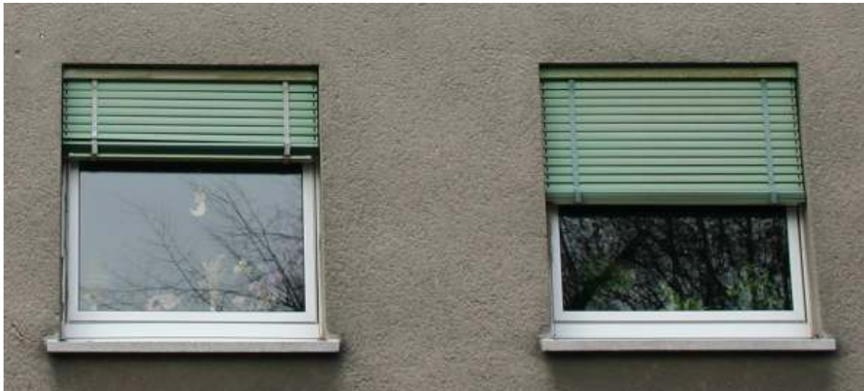
Abbildung 10: Nachträglich eingebaute Jalousien an der Südfassade (Tevesstraße 36-46)
