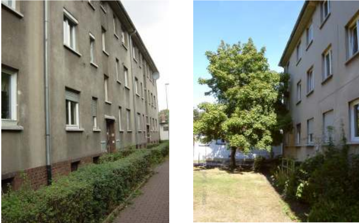
Abbildung 4: Fassadenansicht der Bestandsgebäude (Straßenseite/ Hofseite, Photos: PHI)
