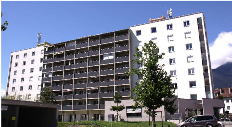
ABBILDUNG 32: ANSICHT AUF DAS GEBÄUDE NACH DER SANIERUNG (QUELLE: PHI)
