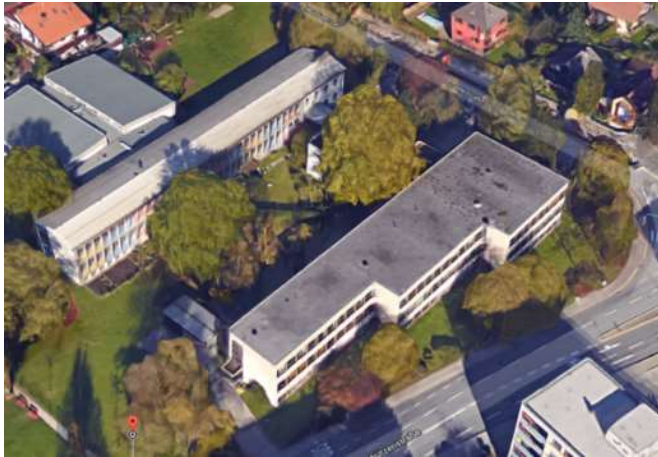
ABBILDUNG 21: ANSICHT AUF DAS GEBÄUDE NACH DER SANIERUNG (QUELLE: GOOGLE.COM)
