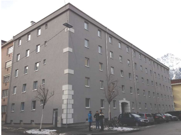
ABBILDUNG 10: GEBÄUDEANSICHT NACH DER SANIERUNG (QUELLE: PHI)
