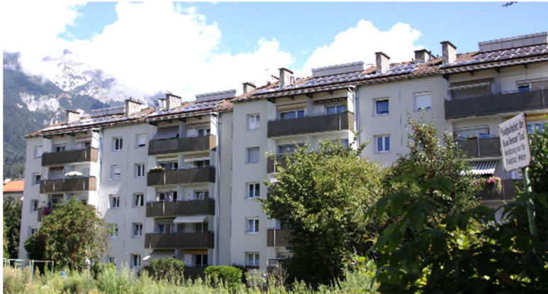
ABBILDUNG 39: GEBÄUDEANSICHT NACH DER SANIERUNG (QUELLE: PHI)
