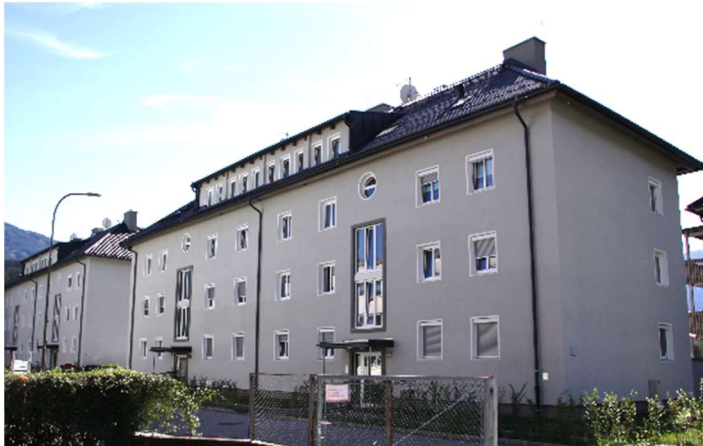
ABBILDUNG 43: GEBÄUDEANSICHT NACH DER SANIERUNG (QUELLE: PHI)
