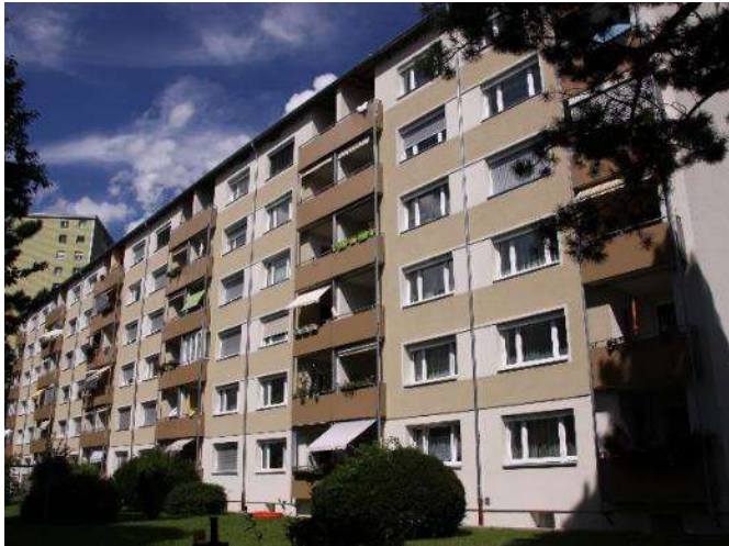
ABBILDUNG 47: GEBÄUDEANSICHT NACH DER SANIERUNG (QUELLE: PHI)
