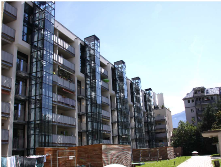
ABBILDUNG 36: ANSICHT AUF DAS GEBÄUDE NACH DER SANIERUNG (QUELLE: PHI)
