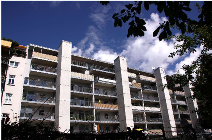
ABBILDUNG 14: ANSICHT AUF DAS GEBÄUDE NACH DER SANIERUNG (QUELLE: PHI)
