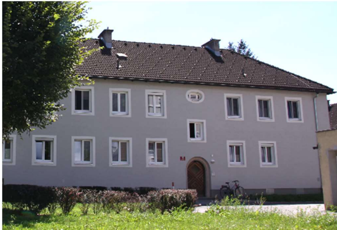
ABBILDUNG 50: GEBÄUDEANSICHT NACH DER SANIERUNG (QUELLE: PHI)
