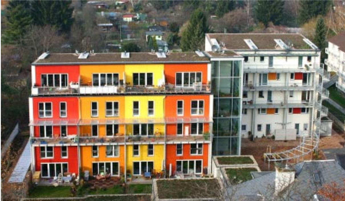
Abbildung 3: Südansicht des Passivhauses vom Kirchturm St. Jakob aus aufgenommen; links "Haus A" mit vorbildlicher Orientierung übergehend zum verglasten Treppenhaus, rechts Haus B von der Erschließungsseite aus mit nur geringem Fensterflächenanteil (Foto: Feist)
