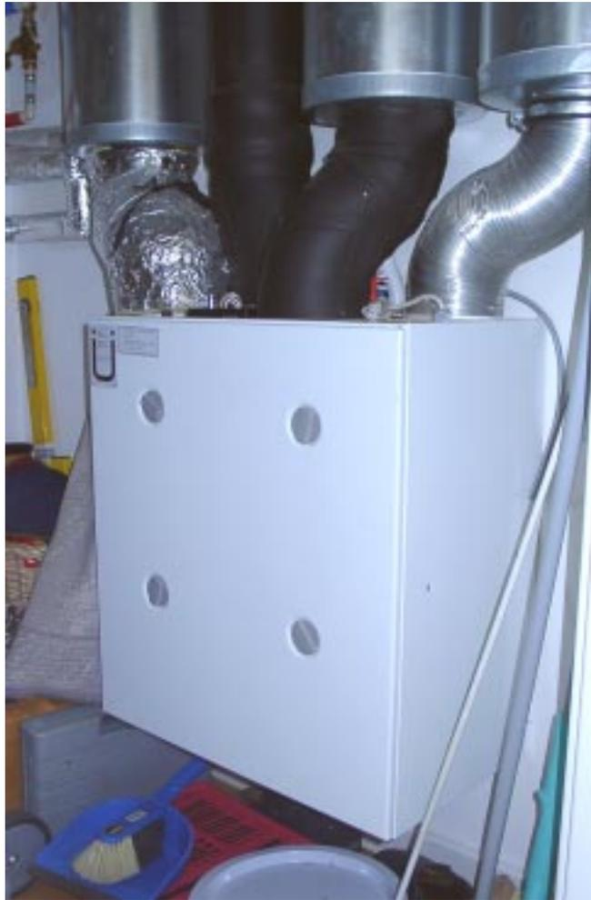
Abbildung 14: Lüftungsanlage mit Wärmerückgewinnung im Abstellraum einer Wohnung.
