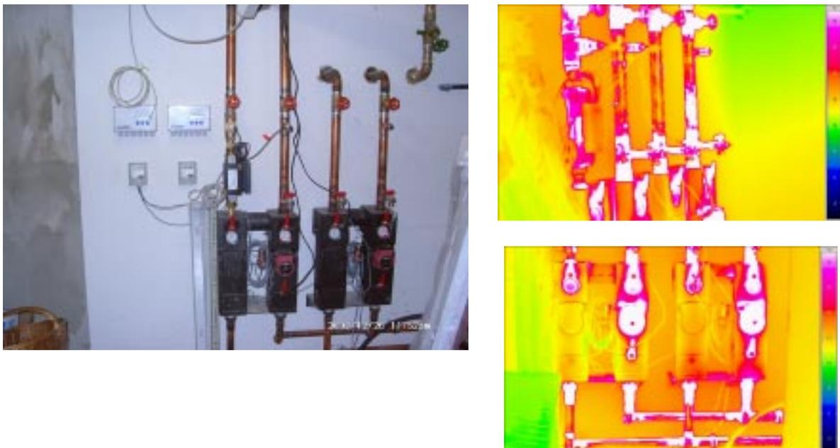
**Abbildung 39:** Pumpengruppe und noch ungedämmte Rohrleitungen im Heizungskeller
