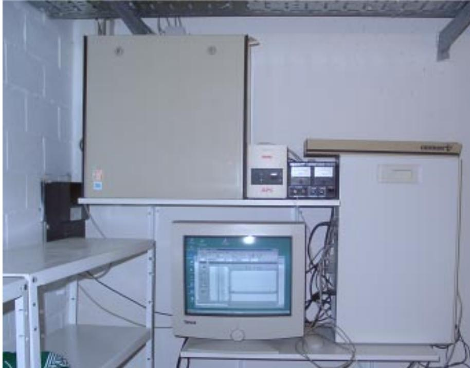
**Abbildung 45: Messtechnik-PC im Technikkeller mit dem Schaltschrank der Wetterstation, Spannungsversorgung der Sensoren und dem M-Bus-Master.**
