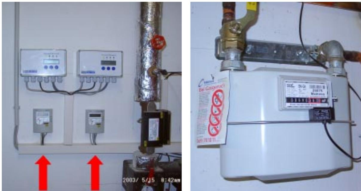
Abbildung 52: Die Rechenwerke der beiden zentralen Wärmemengenzähler für Haus A und B (links) und der Gaszähler mit Niederfrequenz-Impulsgeber (rechts)
