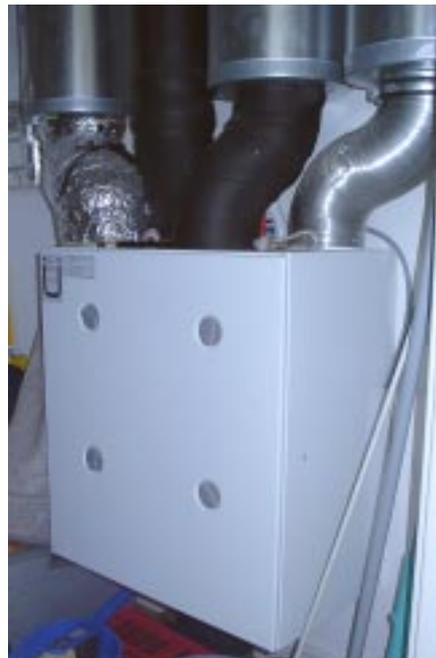
Lüftungsgerät mit Wärmerückgewinnung im Abstellraum einer Wohnung
