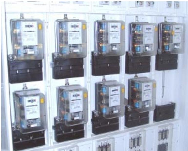
Abbildung 53: Zählerfeld mit Haushalts-Stromzählern im Technikkeller
