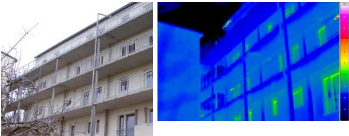
**Abbildung 36:** Nordfassade von Haus A mit der Laubengängerschließung. Die Thermographie zeigt keine Auffälligkeiten.
