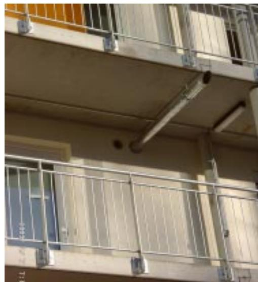
Abbildung 15: Zwei Beispiele für die Anordnung der Außen- und Fortluftöffnungen bei den Gebäuden.
