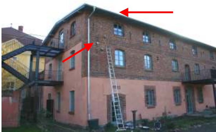
Pyromometer an der Speicherwand, Dachüberstand
