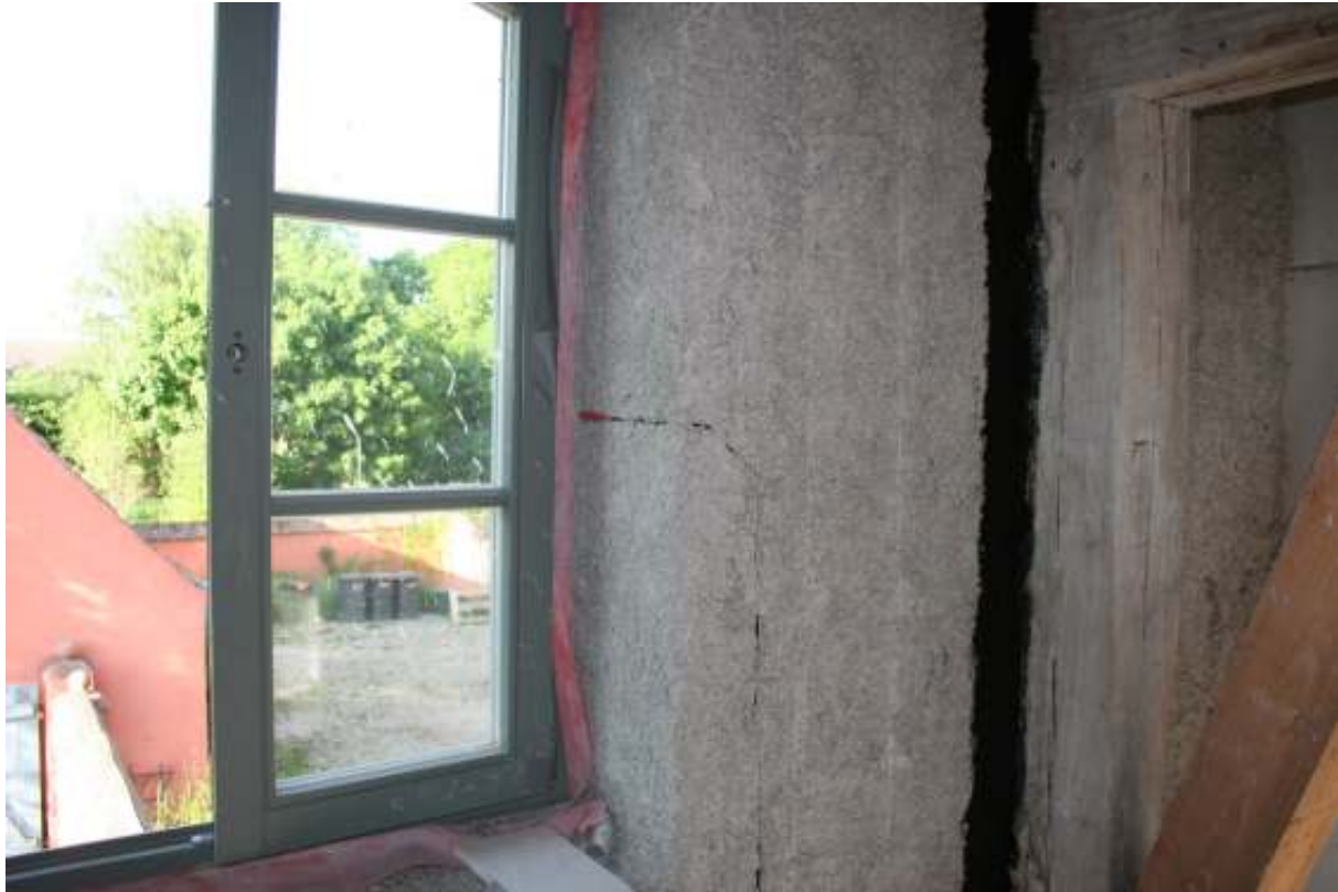
Sensor Oberflächentemperatur Fensterlaibung, noch unverputzt (OG) Abbildung 28
