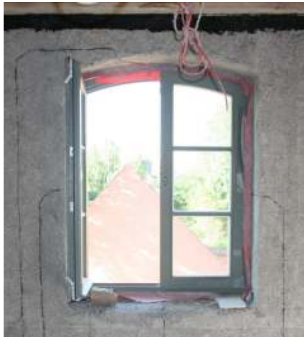
Fenstereinbau: Schematischer Schnitt, Foto Laibunsdämmung und Dichtbänder vor dem Umschlagen
