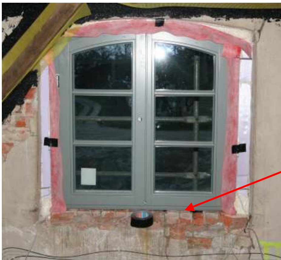
Fenstereinbau DG, Bauzustand
