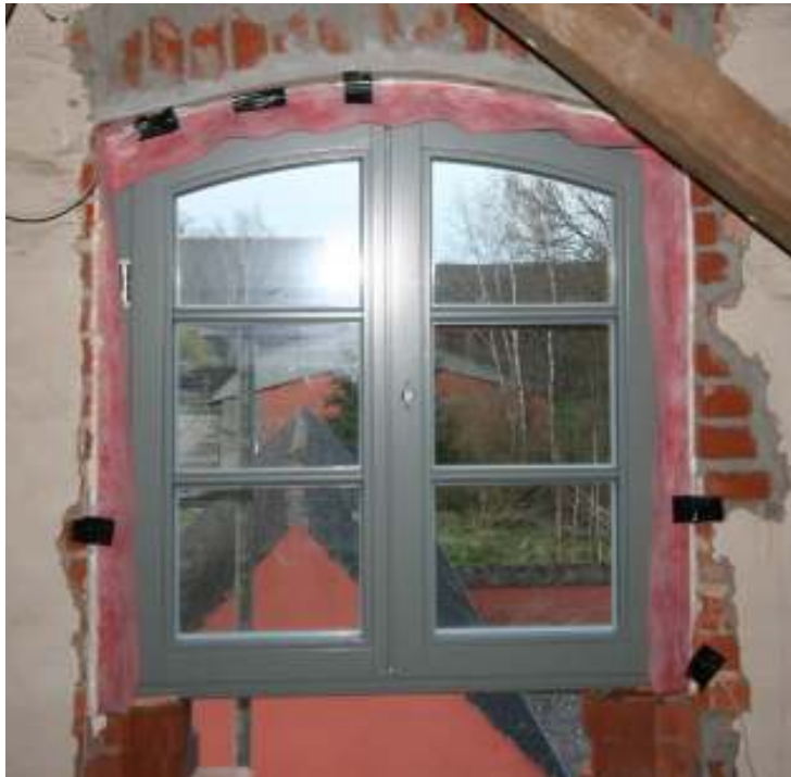
Fenstereinbau OG, Bauzustand
