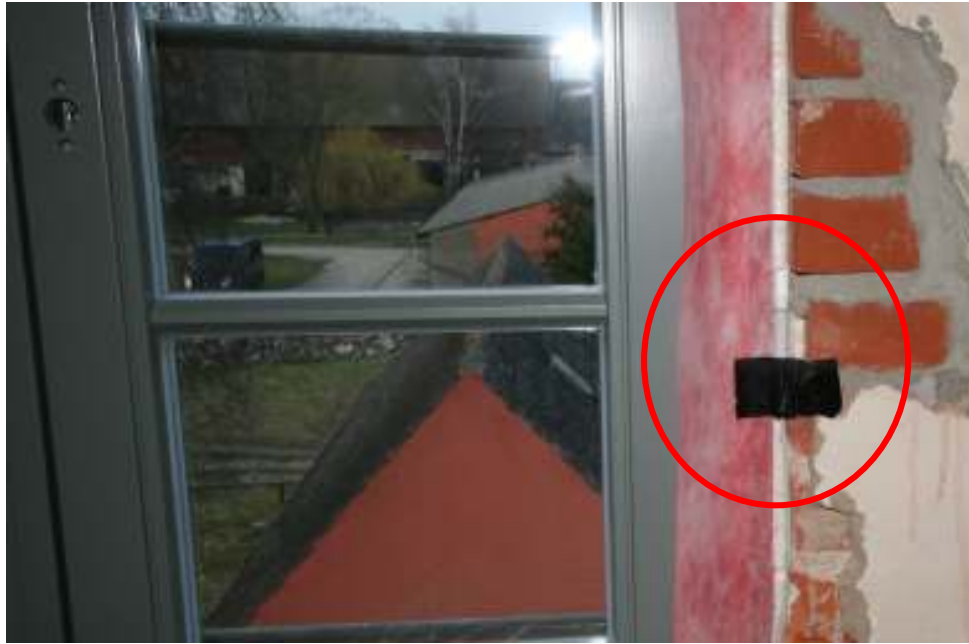
Lage des Temperatur/Feuchte Fühlers in der Fensterlaibung OG
