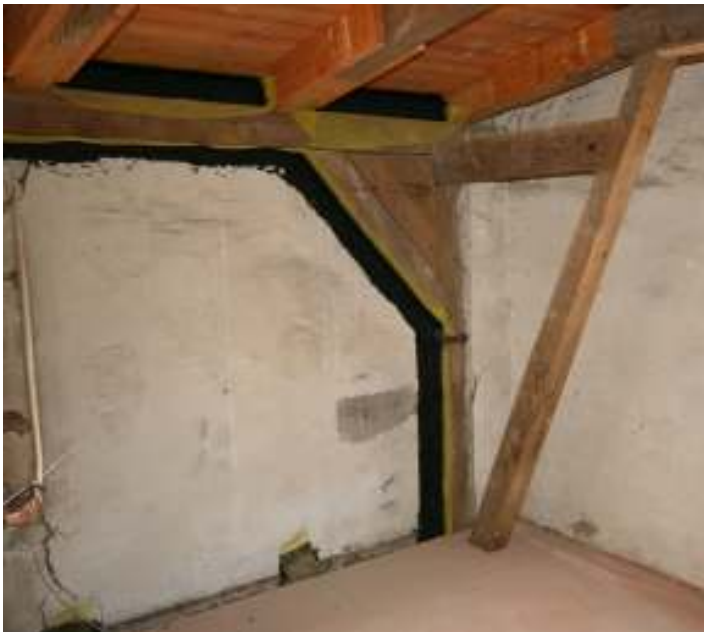
Andichtung der ersten Ebene bei Stützen, Schwellen und Streichbalken
