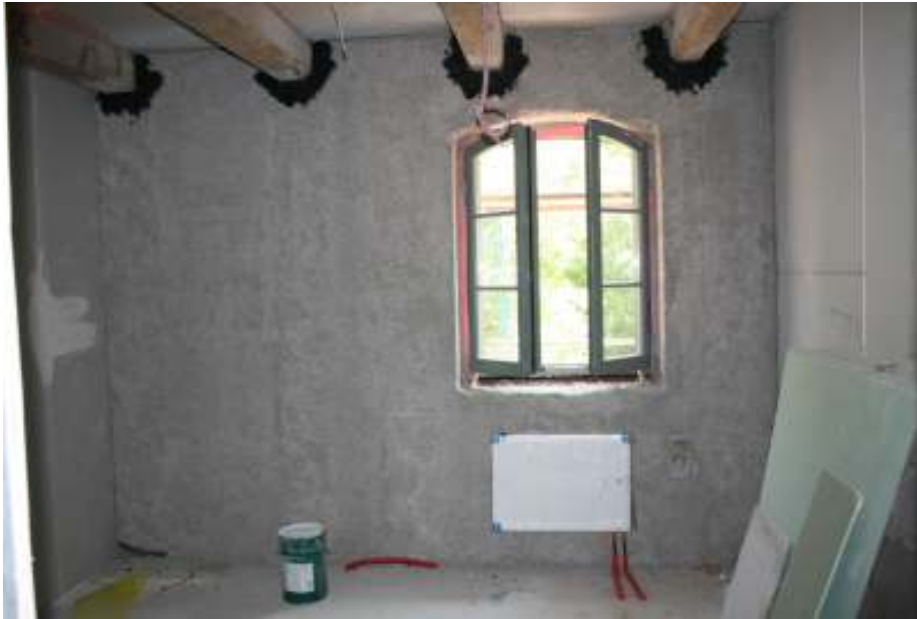
Deckenbalken mit fertiger Dämmschicht und zweiter Dichte Ebene
