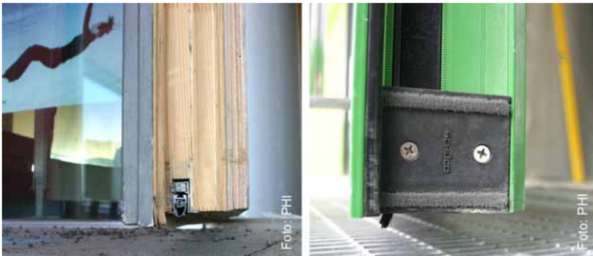
Abbildung 27: Außentüren mit Absenk- und Anschlagdichtung. Eingangstüren sollten nach Möglichkeit eine Anschlagdichtung aufweisen. Eingangstüren von Passivhaus-Schulen (links: Frankfurt Riedberg, Architektur: 4a, Stuttgart / rechts: Schulpavillon Walldorf, Architektur: IB W. Herrmann, Walldorf).
