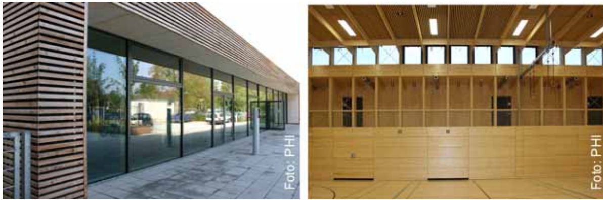
Abbildung 18: Links: Passivhaus-Sporthalle Unterschleißheim in Mischbauweise. Architektur: PSA-Architekten, München. Rechts: Passivhaus-Sporthalle Zentgrafenschule in Holzbauweise, Frankfurt a.M. / Architektur: D'Inka Scheible Hoffmann Architekten.
