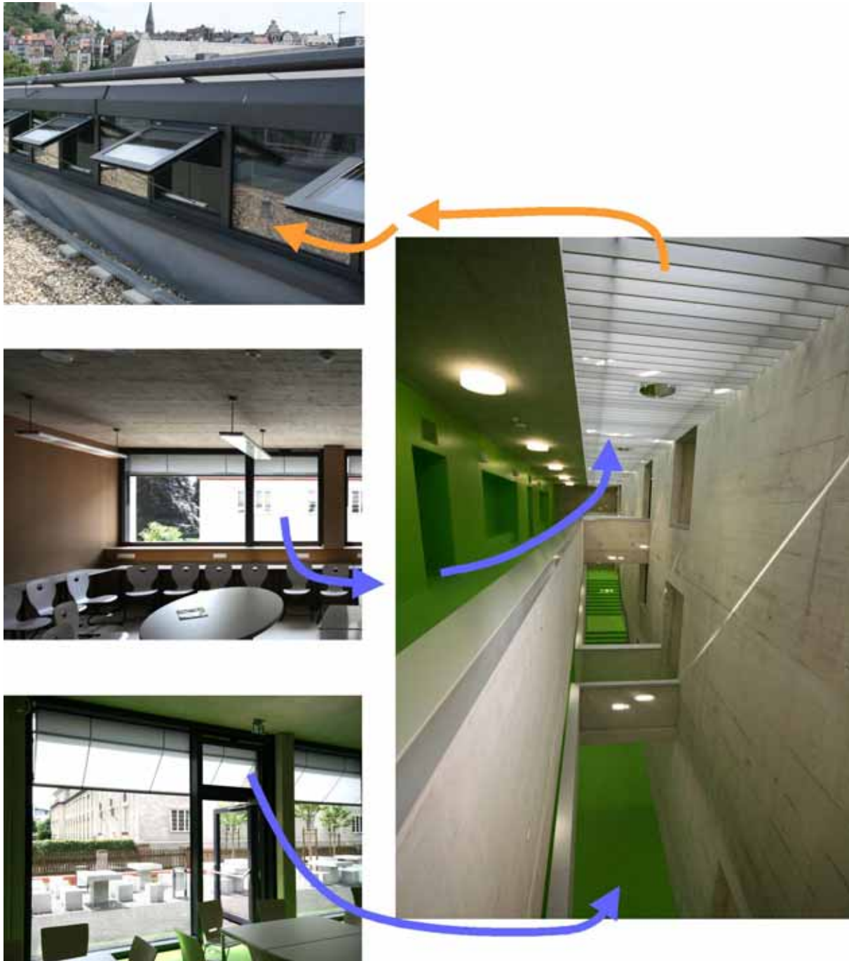
Abbildung 112: Freie Nachtlüftung in einer Schule mittels Kamineffekt. Nachts öffnen sich Lüftungsklappen in den relevanten Aufenthaltsräumen. Die Türen zum zentralen Treppenhaus können nachts durch Türaufhalter offen gehalten werden. Die in den Aufenthaltsräumen erwärmte Nachtluft kann das Gebäude über die in der Dachlaterne geöffneten RWA-Klappen verlassen. Passivhaus-Schule in Marburg (Martin-Luther-Schule). Architekten Hess/Talhof/Kusmierz, München. (Fotos: Passivhaus Dienstleistung GmbH)
