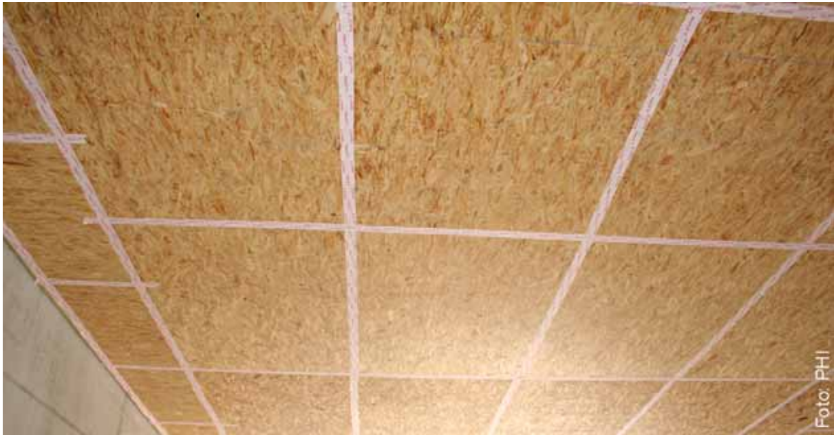
Abbildung 38: Luftdichte Verklebung der Stöße von Holzwerkstoffplatten mit Spezial-Kleband. Deckenuntersicht des Schul-Pavillon Walldorf. Architektur: IB W. Herrmann, Walldorf.
