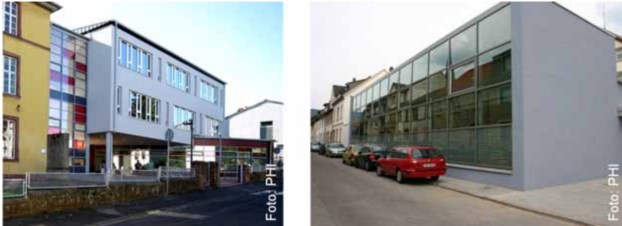
Abbildung 13: Fassaden mit Warmedämmverbundsystem. Links: Albert-Schweitzer-Gymnasium in Alsfeld. Architektur: BLFP, Friedberg. Rechts: Sporthalle in Heidelberg. Architektur: ap 88, Heidelberg
