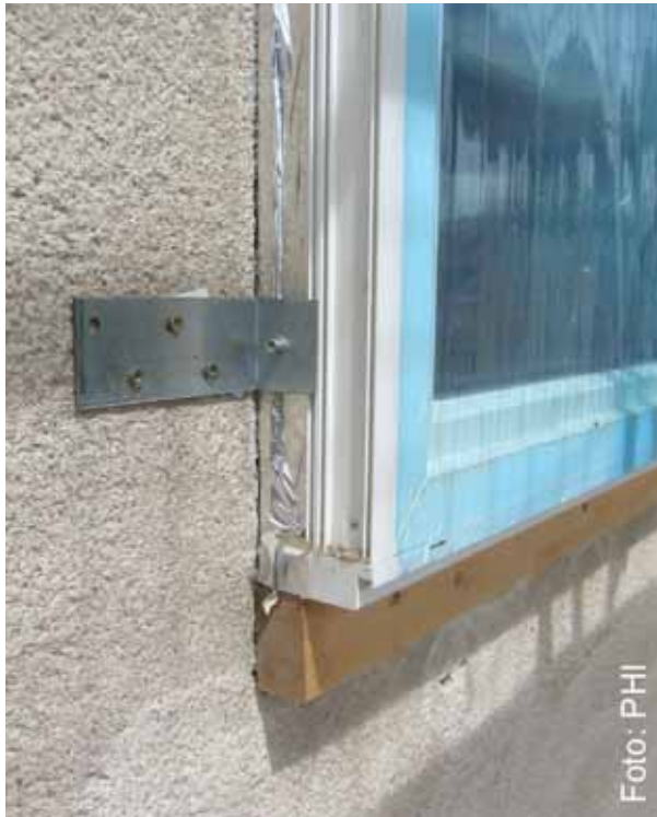
Abbildung 25: Fenstereinbau mit Konsole aus Holz (unten) und Stahlwinkeln seitlich. Ein Wärmedämm-Verbundsystem wird anschließend angebracht bzw. der Rahmen wird überdämmt. [Kaufmann/Peper 2009]
