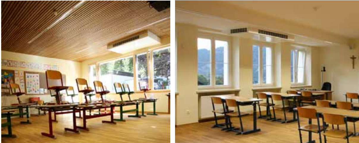
Abbildung 58: Dezentrales Lüftungskonzept bei einer Schul-Modernisierung und Erweiterung in Sams (A). Architekt: Raimund Rainer, Innsbruck (Fotos: Simon Rainer)
