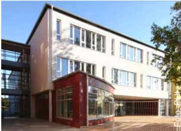
Abbildung 12: Vorhangfassade in Teilbereichen des Erdgeschosses, Albert-Schweizer-Gymnasium Alsfeld. Architektur: BLFP, Friedberg.
