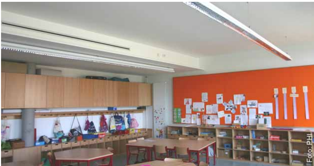
Abbildung 9: Klassenraum in der Passivhaus-Schule Frankfurt-Riedberg. Die Decke ist nur im Bereich der Kanalführung abgehängt (der Zuluft-Schlitz ist erkennbar). Eine Pinnwand an der Klassenrückwand wirkt zusätzlich als Akustik-Element. Architektur: 4a, Stuttgart / Haustechnik: ICRZ Ing. Cons. Ruth + Zimmermann, Neuenhagen
