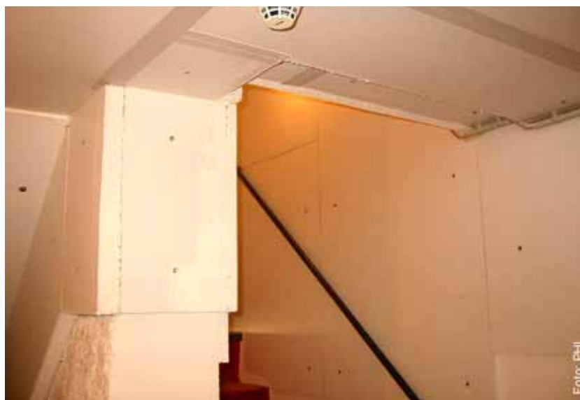
Abbildung 44: Deckendämmung und Begleitdämmung der Wände bei der Kellertreppe nach der Sanierung (Quelle [Kaufmann et al. 2009])
