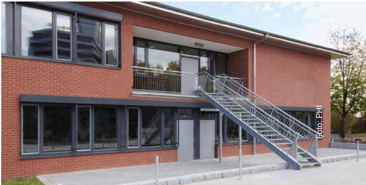
Abbildung 36: Nicht belüftetes Flachdach mit massiver Tragkonstruktion und wärmebrückenarmer Auskragung. Albert-Einstein-Schule in Schwalbach. Heibel + Wirth - Architekten, Frankfurt. (Quelle: Heibel + Wirth Architekten)
