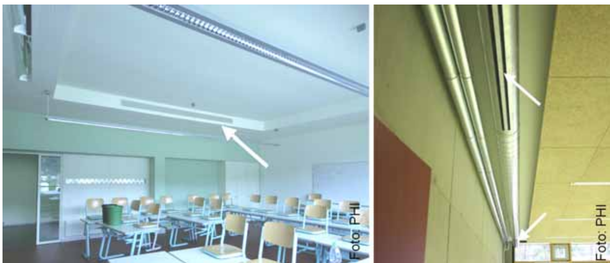
Abbildung 70: Luftauslässe mit hoher Induktion. Links Schlitzauslässe und rechts kanalintegrierte Auslassgitter. Die Luftgeschwindigkeiten am Auslass werden schnell abgebaut, Zegerscheinungen durch die Lufteinbringung können so verringert werden. Durch die räumliche Anordnung der Luftentnahme muss eine vollständige Durchspülung des Raums sichergestellt werden. Passivhaus-Schule Neckargemünd (links): Architektur: Donnig + Unterstab, Rastatt / Haustechnik: IWP GmbH, Stuttgart Passivhaus-Schule-Pavillon Walldorf (rechts): Architektur: IB W. Herrmann, Walldorf / Haustechnik: Gadow + Graeske, Walldorf.
