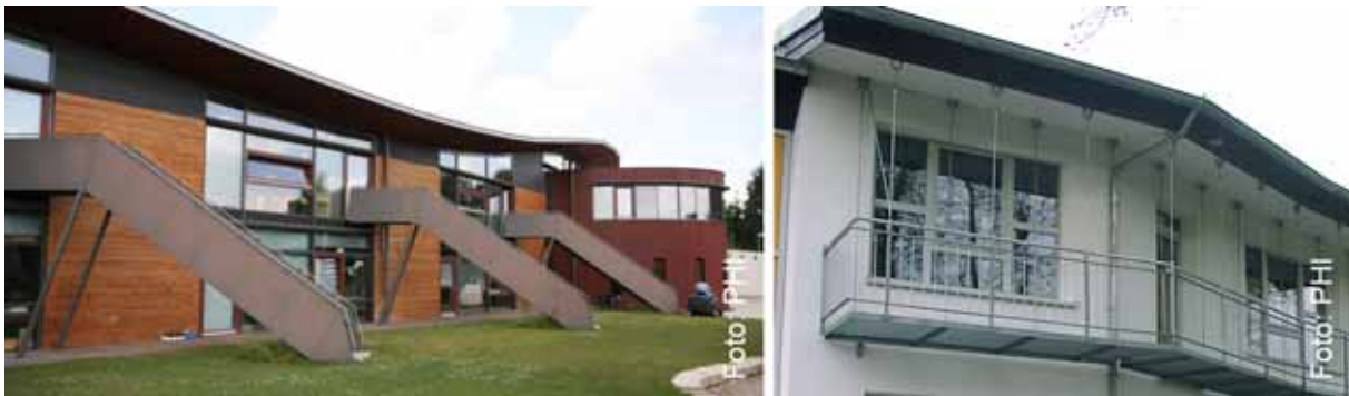
Abbildung 20: Links: Fluchttreppen der Montessori-Schule in Aufkirchen. Walbrunn Grotz Vallentin Architekten, Bockhorn. Rechts: Abgehängter Fluchtbalkon an der Freien Walldorfschule Bremen Sebaldsbrück. Architekten: Prof.W.Dahms und F. Sieber, Bremen.
