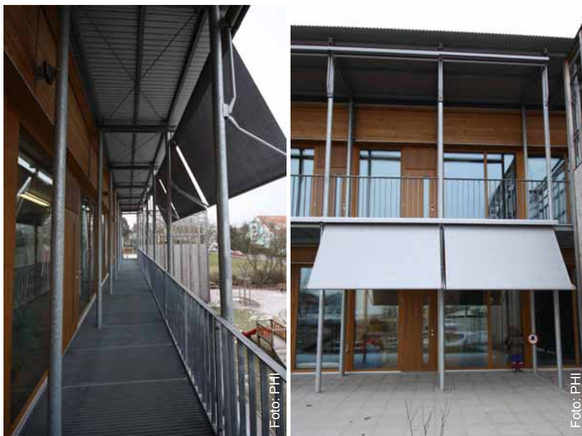
Abbildung 106: Der Sonnenschutz der südorientierten Kindertagesstätte wurde über einen Dachüberstand sichergestellt. Aufgrund der raumhohen Fenster ist eine zusätzliche Markise zur Verschattung erforderlich. Durch die außenseitige Anordnung der Markise kann der Sonnenschutz auch im Bereich der Gruppenraumtür durchlaufen. In der Übergangszeit kann das Gebäude jedoch nicht vollständig verschattet werden. Kindertagesstätte in Frankfurt Schwanheim / Architektur: sdks, Darmstadt
