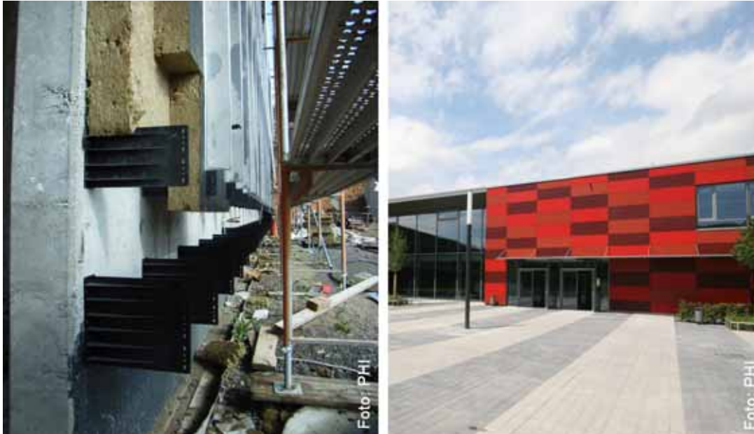
Abbildung 16: Schulzentrum Neckargemünd, Vorhangfassade mit Kunststoff-Konsolen. Architektur: Donnig und Unterstab, Rastatt.
