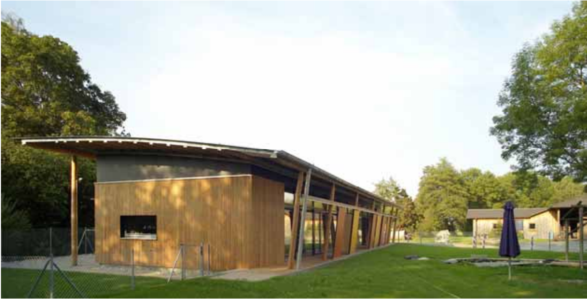
Abbildung 7: Auch kleinere, eingeschossige Gebäude erreichen den Passivhaus-Standard - allerdings mit etwas erhöhtem Aufwand Kinderkrippe in Lengdorf, Architekt: Gernot Vallentin (Foto: Gernot Vallentin)
