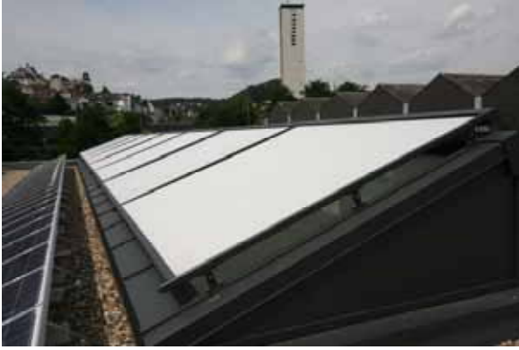
Abbildung 107: Sonnenschutz von Dachoberlichtern. Passivhaus-Schule in Marburg (Martin-Luther-Schule). Architekten Hess/Talhof/Kusmierz, München. (Foto: Passivhaus Dienstleistung GmbH)
