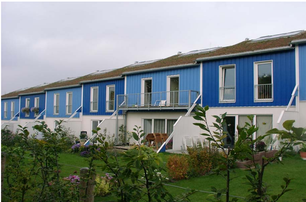
Abb. 1: Südfassade einer Hauszeile (Ausschnitt) der Passivhaussiedlung Hannover-Kronsberg.
